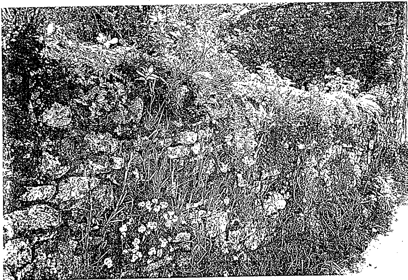
Tout le charme d'un vieux mur.
